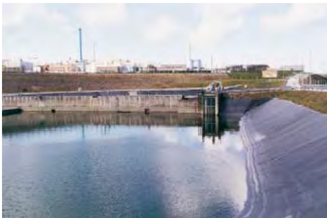
Bassin de stockage
