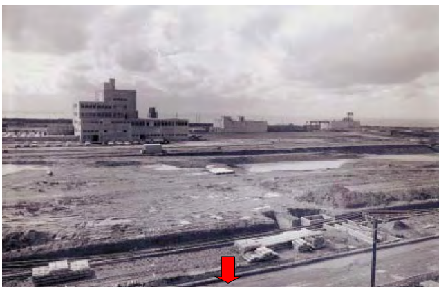
Etablissement de La Hague en 1965 avec, de gauche à droite, STE2, l'entreposage des boues et le silo 115.
