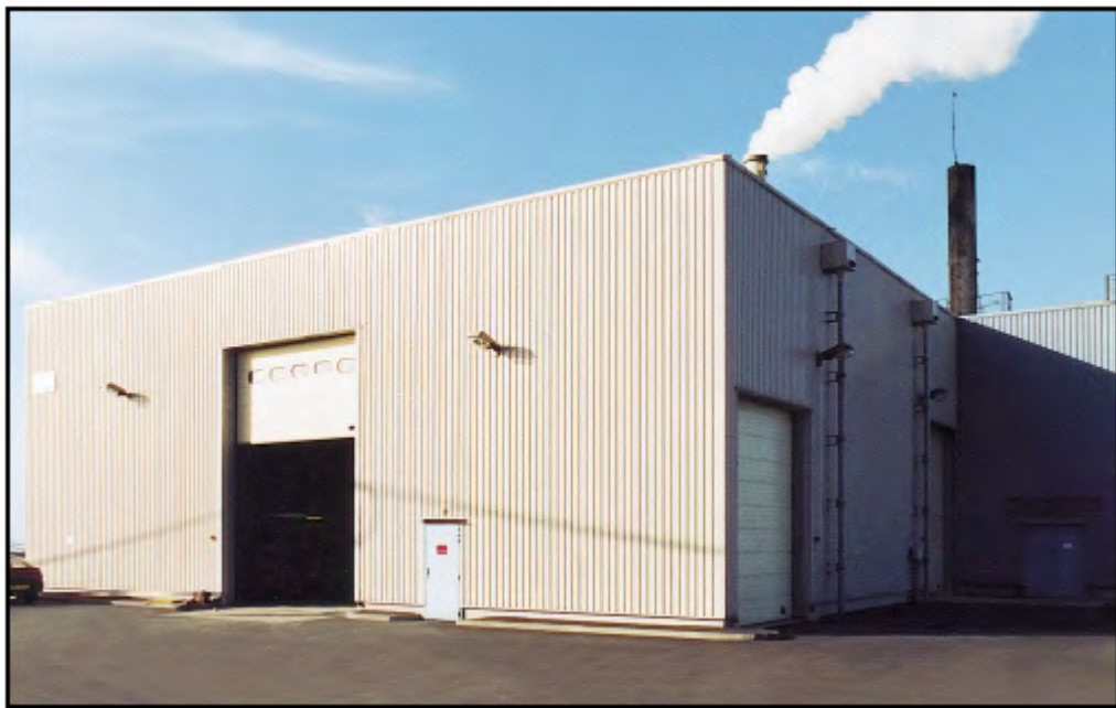
Unité d'incinération des déchets banals
